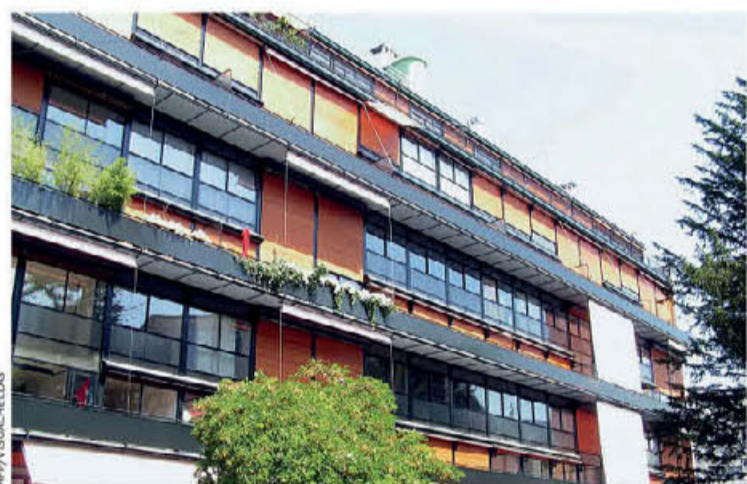
Το Immeuble Clarté του Λε Κορμπιζιέ στη Γενεύη διατηρεί ακόμη πολλά από τα αρχικά εξωτερικά του στοιχεία (μπαλκόνια, τέντες, ρολά).
